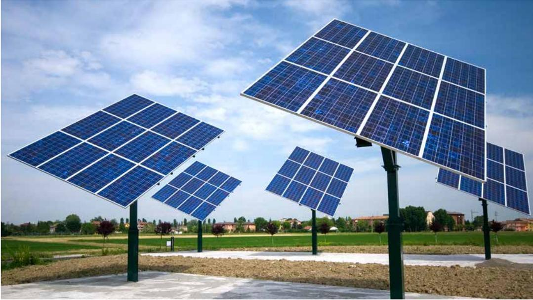
我们可以捕获太阳能，如利用太阳能电池。许多组装在一起的太阳能电池称作太阳能电池板。太阳能电池板用来捕获太阳能，并将其转换为更易于利用的形态，比如热或电。太阳能相关技术有：
